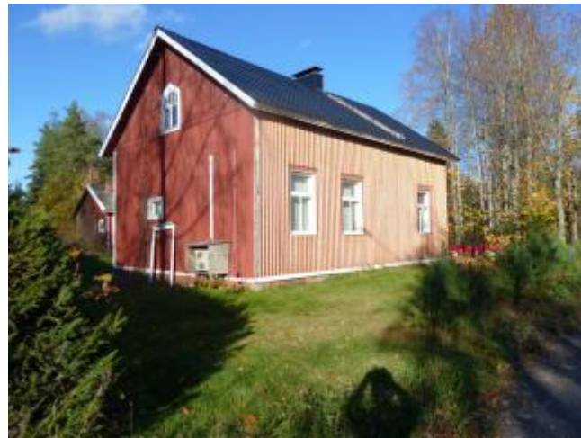
Torppakyläntien entinen kaupparakennus.
